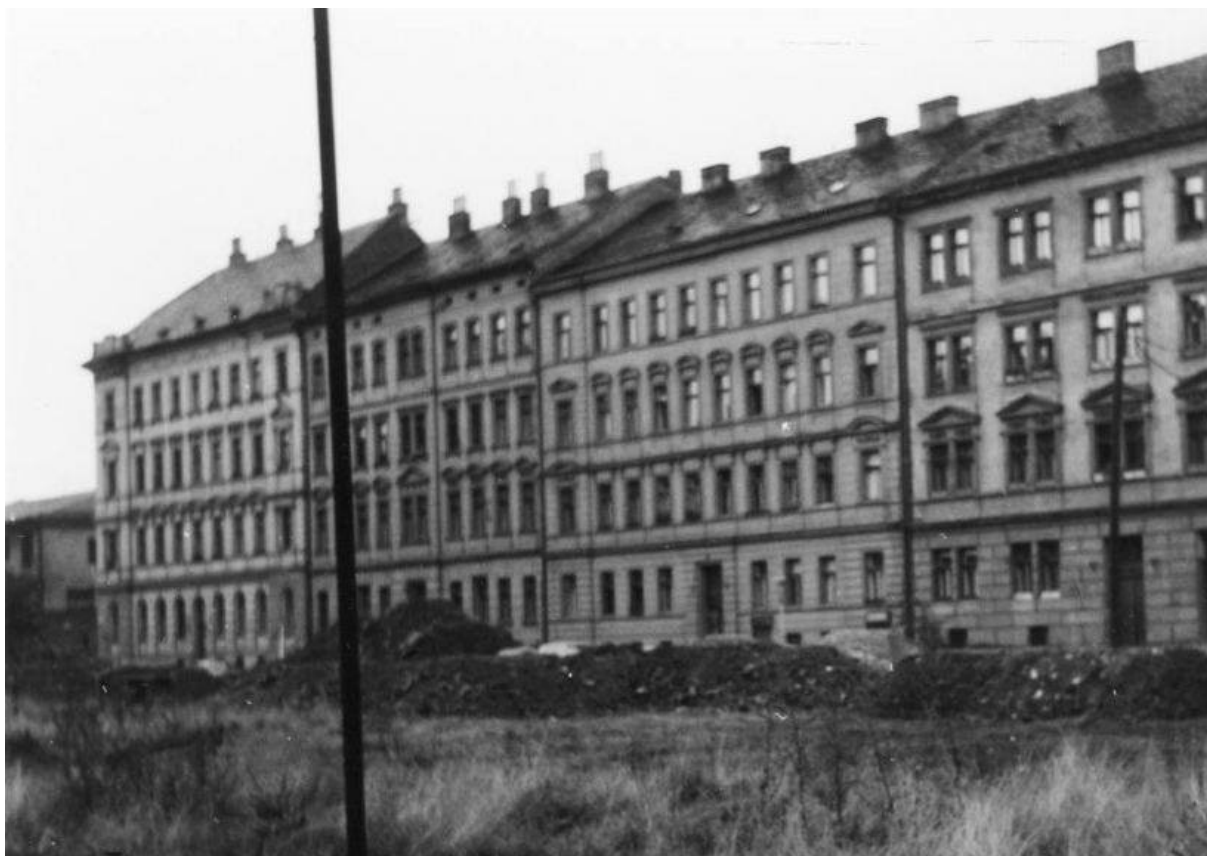
Ulice Arnoštovská před demolicí v r. 1978
